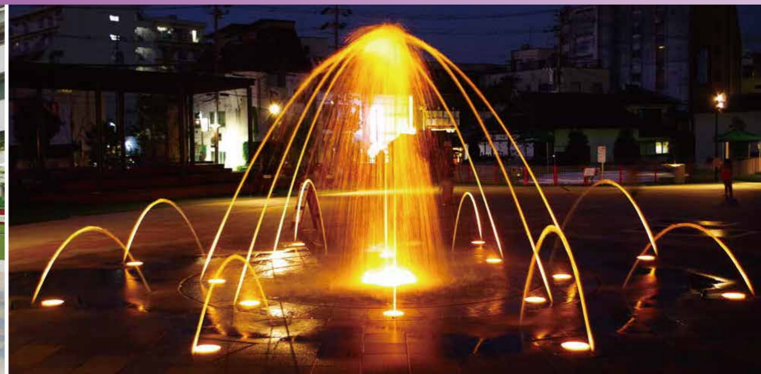
△ 噴水とじゃぶじゃぶ池を設計施工。中央に向かって二重のアーチ噴水が出ており、それぞれ高さが変化する。中央は干満型のじゃぶじゃぶ池と直上噴水がある。夜はライトアップされ、市民の憩いの場となっている。
