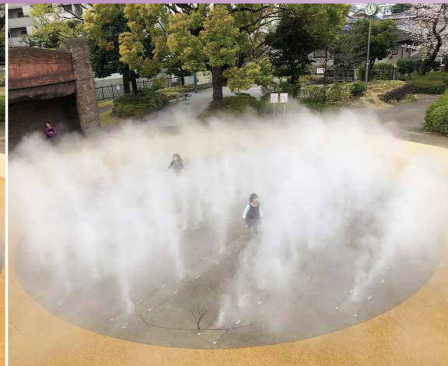
△ ミストを設計施工。噴霧量を変化できる設計になっており、季節にあった噴霧量の演出が自動で運転する。子どもたちは徐々に増えるミストの中を走り抜けて遊べる。気象センサーの追加により、その日の天気によって自動で運転を判断するため、管理も容易になっている。
