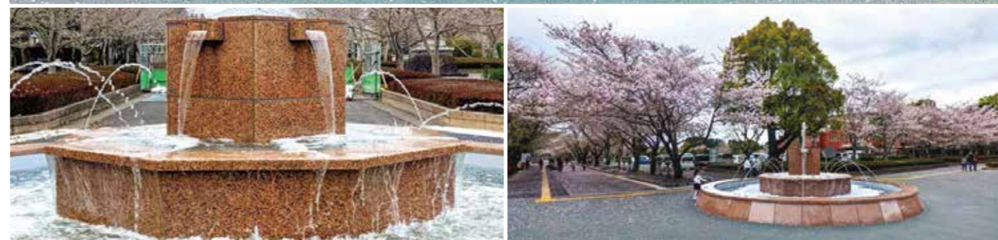
△ 噴水と水盤を設計施工。タイマーで決まった時刻になると演出が始まる。8本のアーチ噴水は個別に制御しており、中央の噴水が出ると水が溢れて水盤へと流れていく。
