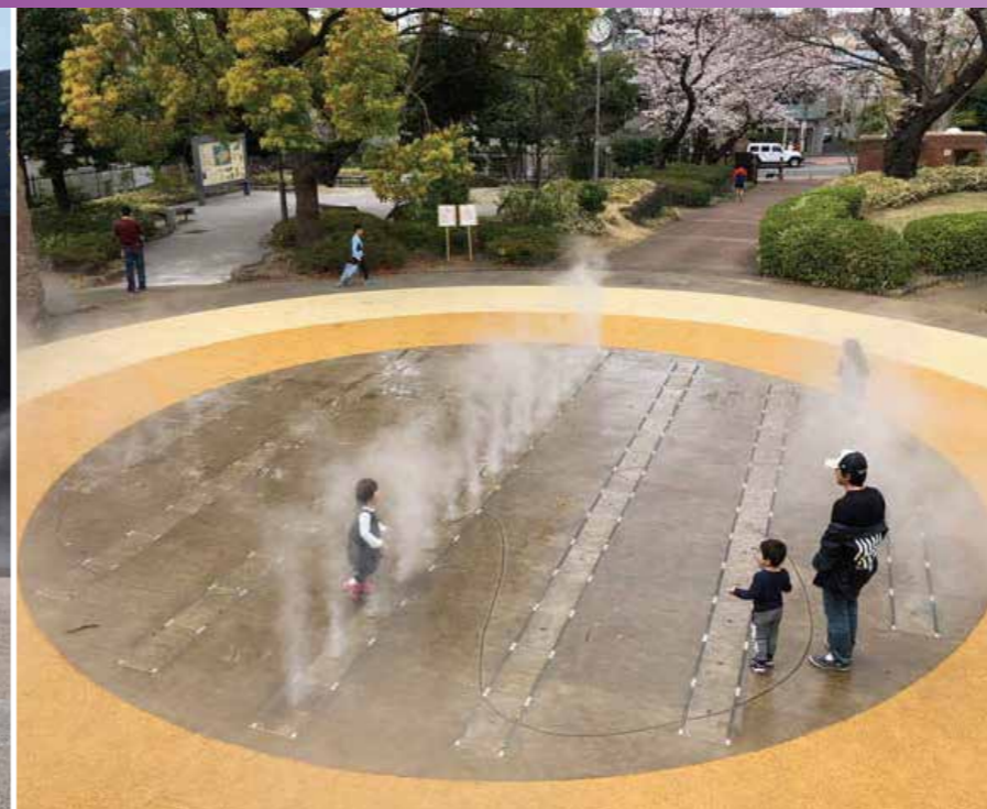
△ ミストを設計施工。噴霧量を変化できる設計になっており、季節にあった噴霧量の演出が自動で運転する。子どもたちは徐々に増えるミストの中を走り抜けて遊べる。気象センサーの追加により、その日の天気によって自動で運転を判断するため、管理も容易になっている。
