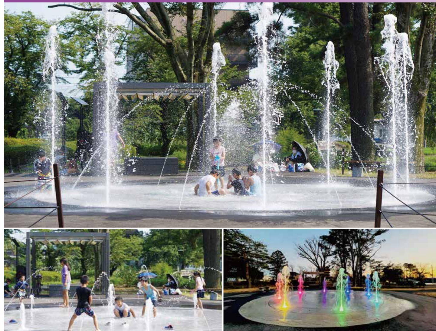
△ 噴水とじゃぶじゃぶ池を設計施工。直上噴水とアーチ噴水を交互に円形配置。中央は干満システムのじゃぶじゃぶ池となっている。夜は直上噴水がライトアップされ楽しめる。
